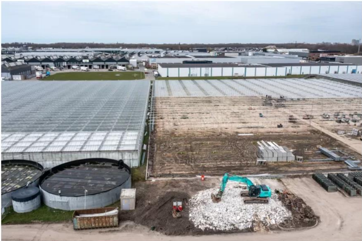
▲ De sloop van kassen ten behoeve van de uitbreiding van ABC Westland was vorig jaar reeds in volle gang. © Thierry Schut
